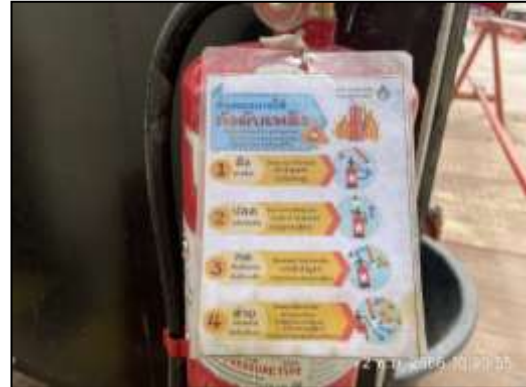
ภาพที่ 33 ถังดับเพลิงเคมี และป้ายแนะนำการใช้งาน
