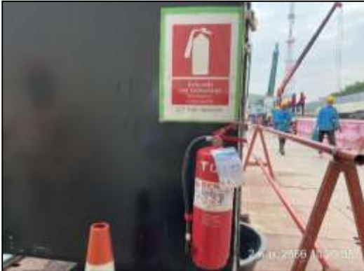
ภาพที่ 33 ถังดับเพลิงเคมี และป้ายแนะนำการใช้งาน
