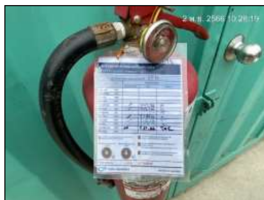
ภาพที่ 66 ตรวจเช็คสภาพถังดับเพลิง
