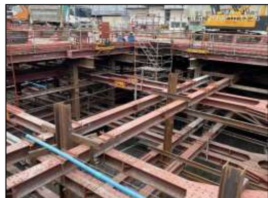
ภาพที่ 20 กำแพงกันดิน และระบบค้ำยันเหล็ก
