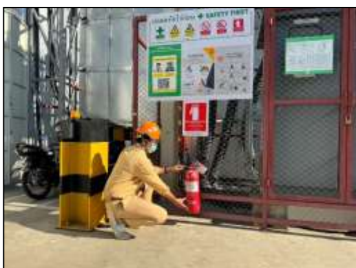
ภาพที่ 66 ตรวจเช็คสภาพถังดับเพลิง
